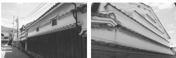
土佐漆喰の白壁に水切り瓦が2層、3層、4層
