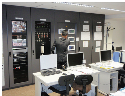
コントロールセンター
