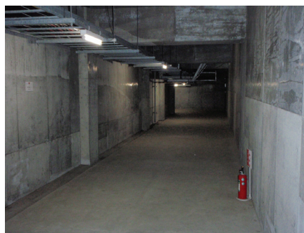
クールヒートトレンチ内部
