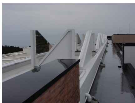
ライトウェル（屋上の光取入口）
