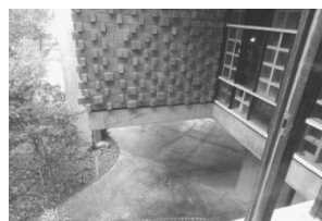
2階からピロティを見る
