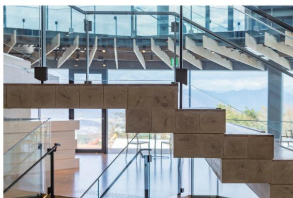
階段両端のひのき断面・踏板はバーチ材
