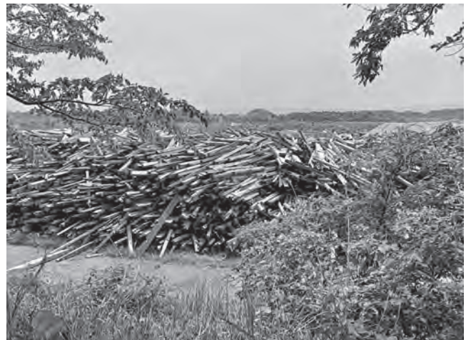
解体された建物の瓦（20241221、珠洲市鉢ヶ崎）
