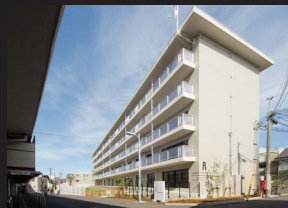
高円寺アパートメント
