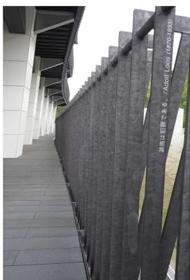
リン酸亜鉛処理によるバルコニー手すり
