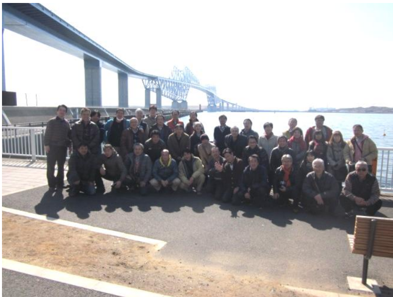
東京ゲートブリッジ (2012)
