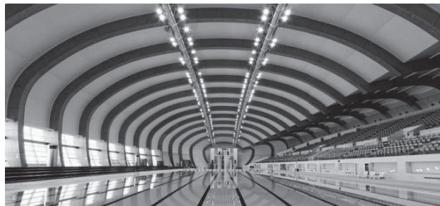
2015 年 富士水泳場天井改修
