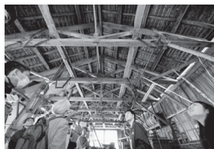
●製茶工場内部/小屋組み。
