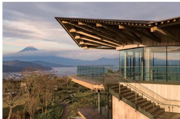
日本平夢テラス（写真提供：川澄・小林研二写真事務所）
