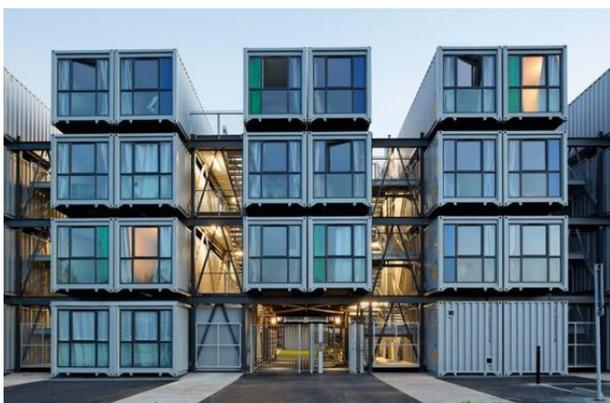
の組み合わせにより共同住宅や店舗、事務所などのシステム建築化の可能性が大きい。4) 震災時の避難用の仮設住宅などの短期使用が可能な復興住宅、その後の移設及び転用などに臨機応変に対応が可能となる。など、コンテナ建築の可能性は大きいと感じませんか?
