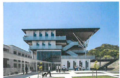
静岡理科大学建築学科棟 えんつりー (設計: 古谷誠章 + NASCA 施工: 鈴与建設)
